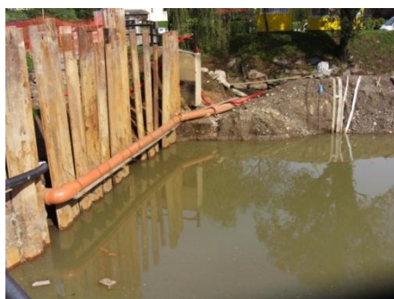
slika 20: začetni izkop gradbene jame ZB2 ob Mučki Bistrici z gladino podtalnice
