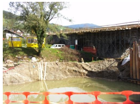
slika 20: začetni izkop gradbene jame ZB2 ob Mučki Bistrici z gladino podtalnice
