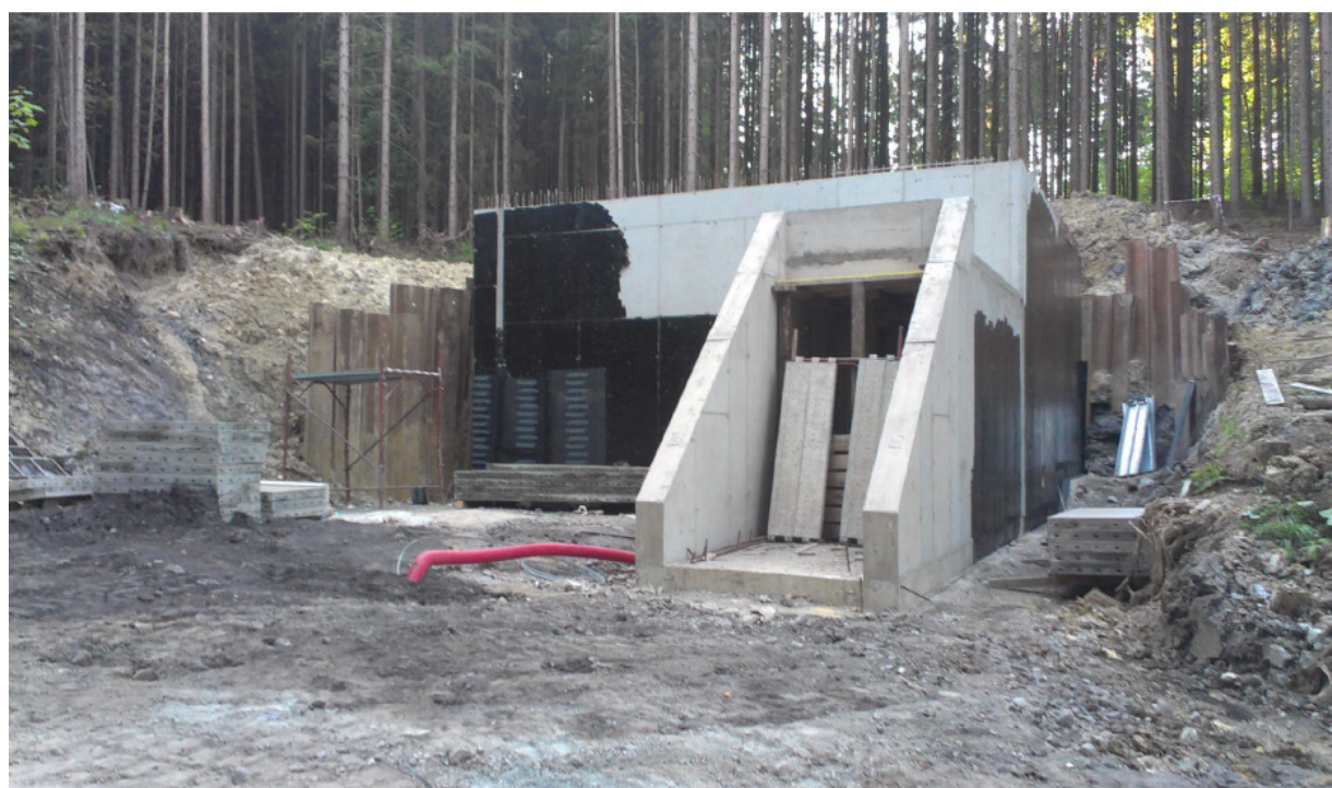
Vodohran Mežica - Stanje objekta 22.07.2013
