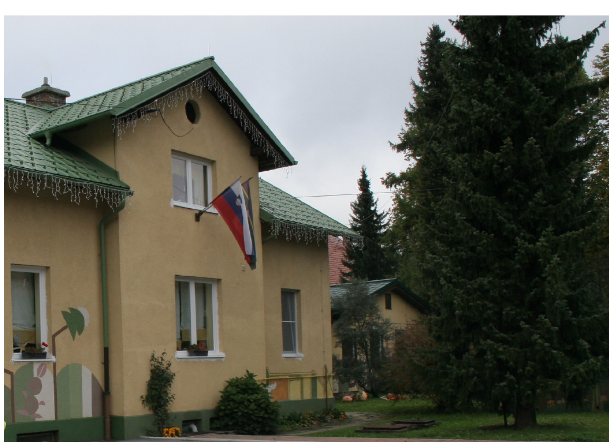
Vrtec Mežica - Stanje objekta 22.07.2013
