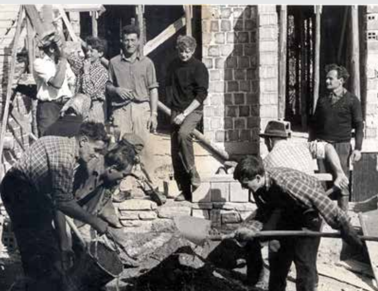
Gradnja družinske hiše v Starem trgu pri Slovenj Gradcu, ok. 1970. Foto: Oto Vončina (osebni arhiv: Simona Vončina)
