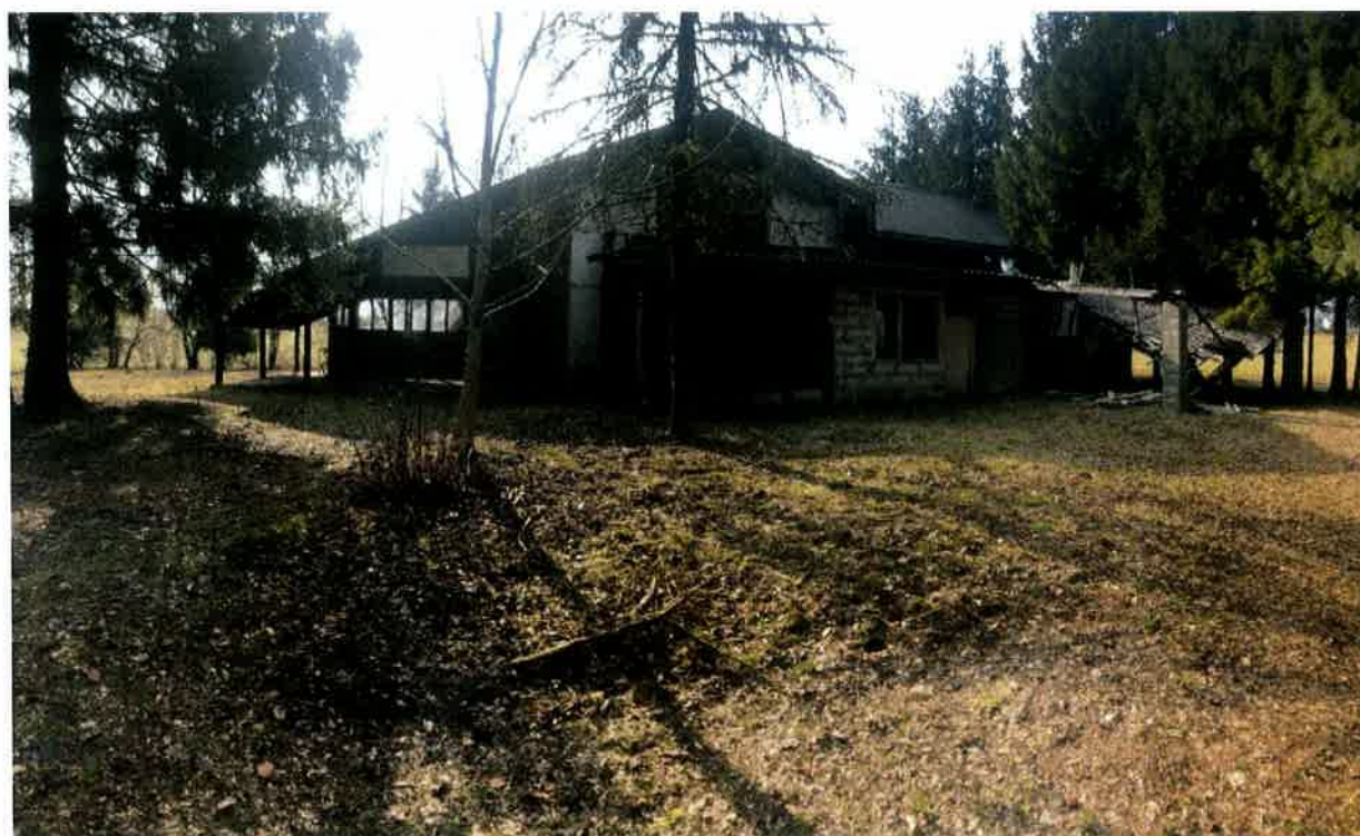
Slika 7: Pogled na severovzhodno stran obstoječega objekta
