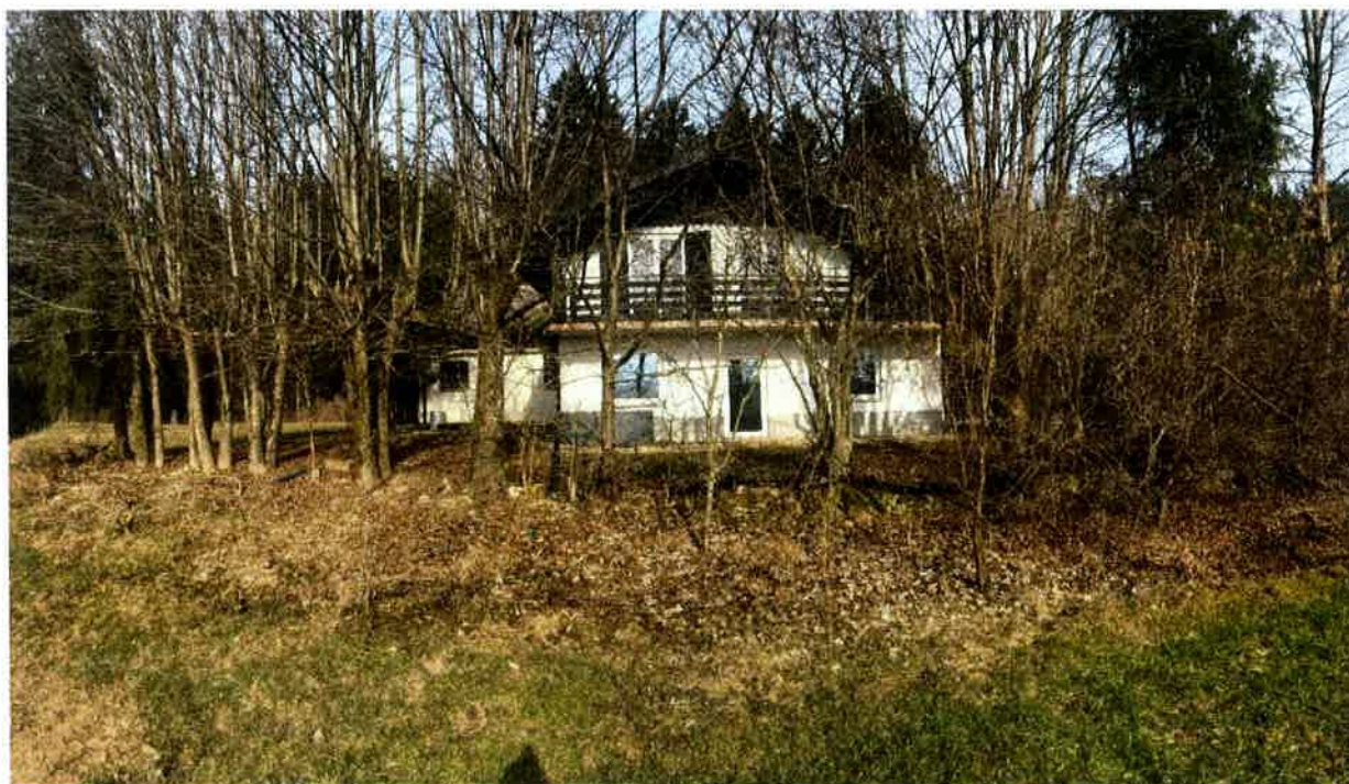
Slika 9: Pogled na jugozahodno stran objekta
