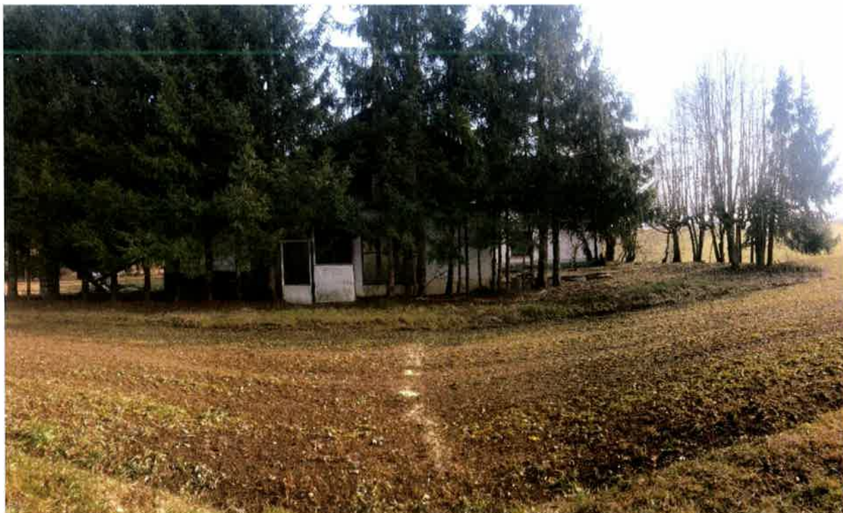
Slika 8: Pogled na severozahodno stran obstoječega objekta
