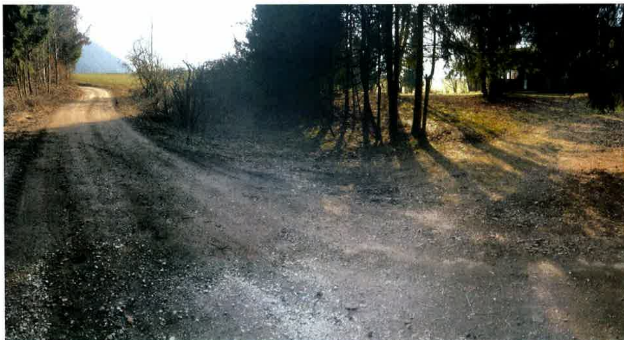
Slika 11: Pogled na javno cesto JP 751137 proti vzhodu, zemljišče parc. št. : 1041 k.o. Zg. Pirniče
