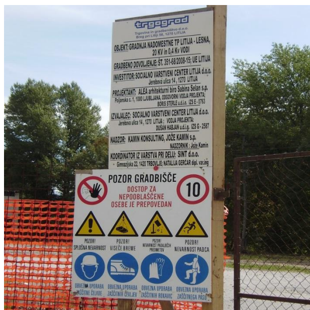
Gradnja nadomestne TP Litija – Lesna (2010).
