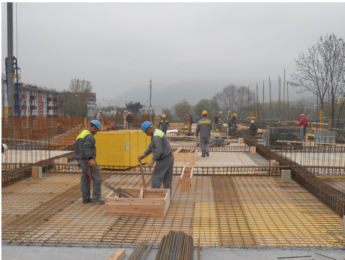
Delo na gradbišču se nadaljuje (2011).
