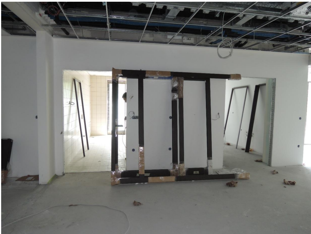
Vgradnja stavbnega pohištva (2013).
