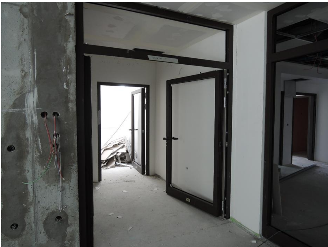
Vgradnja stavbnega pohištva (2013).
