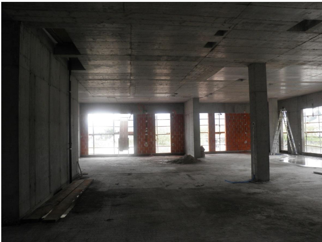
Notranji prostori čakajo na dokončanje del (2012).
