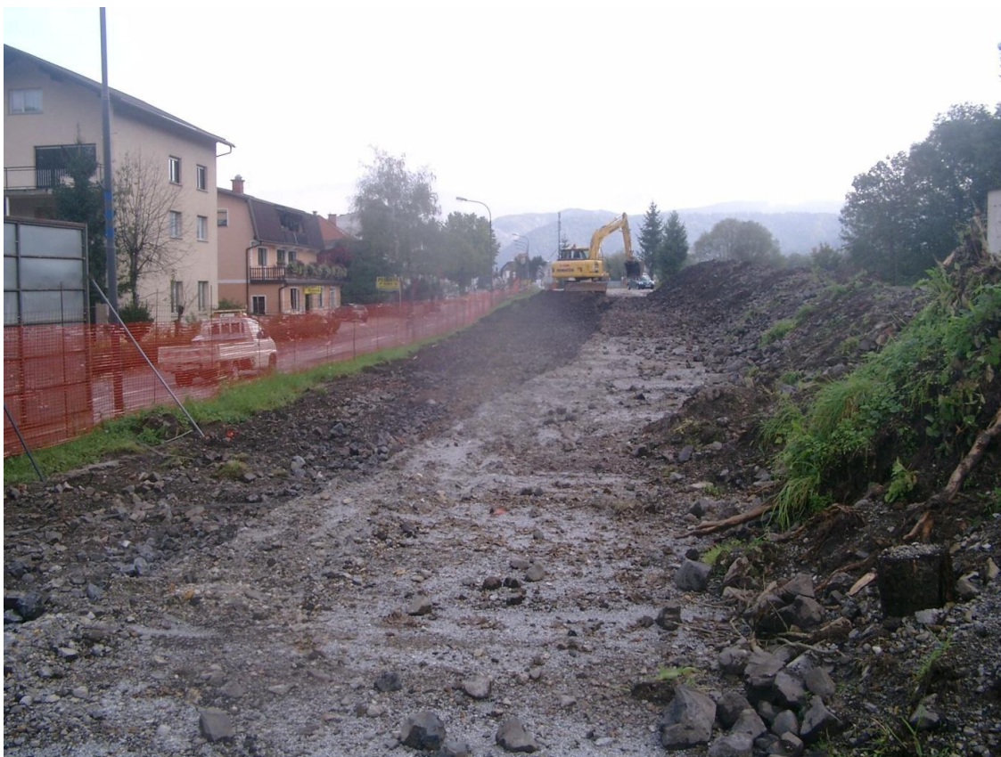
Prestavitev obstoječih kanalizacijskih in elektro vodov (2010).
