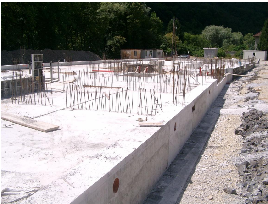
Gradnja temeljne plošče (2011).
