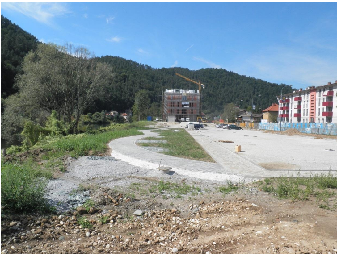
Priprava terena za izgradnjo parkirišča (2012).
