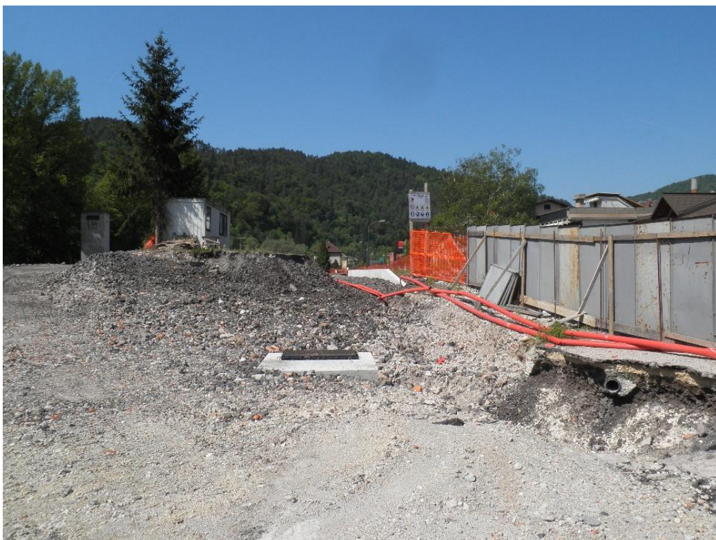
Prestavitev komunalnih vodov in TP postaje (2010).
