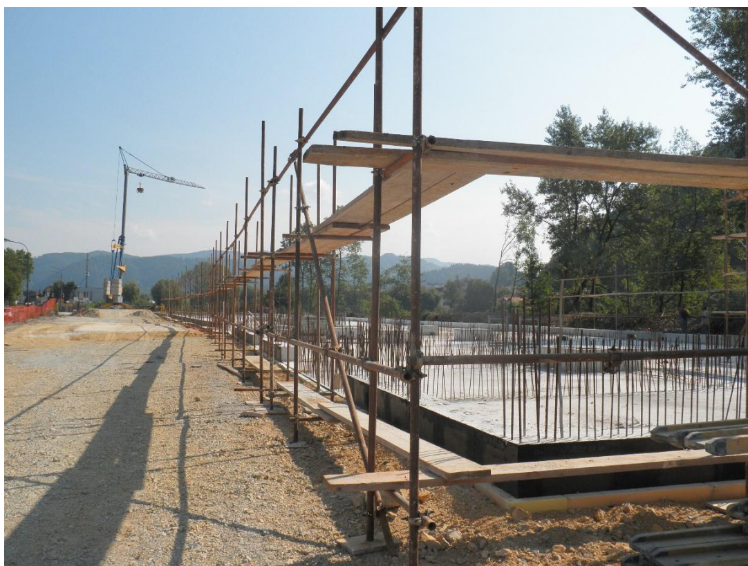
Postavitev gradbenih odrov (2011).
