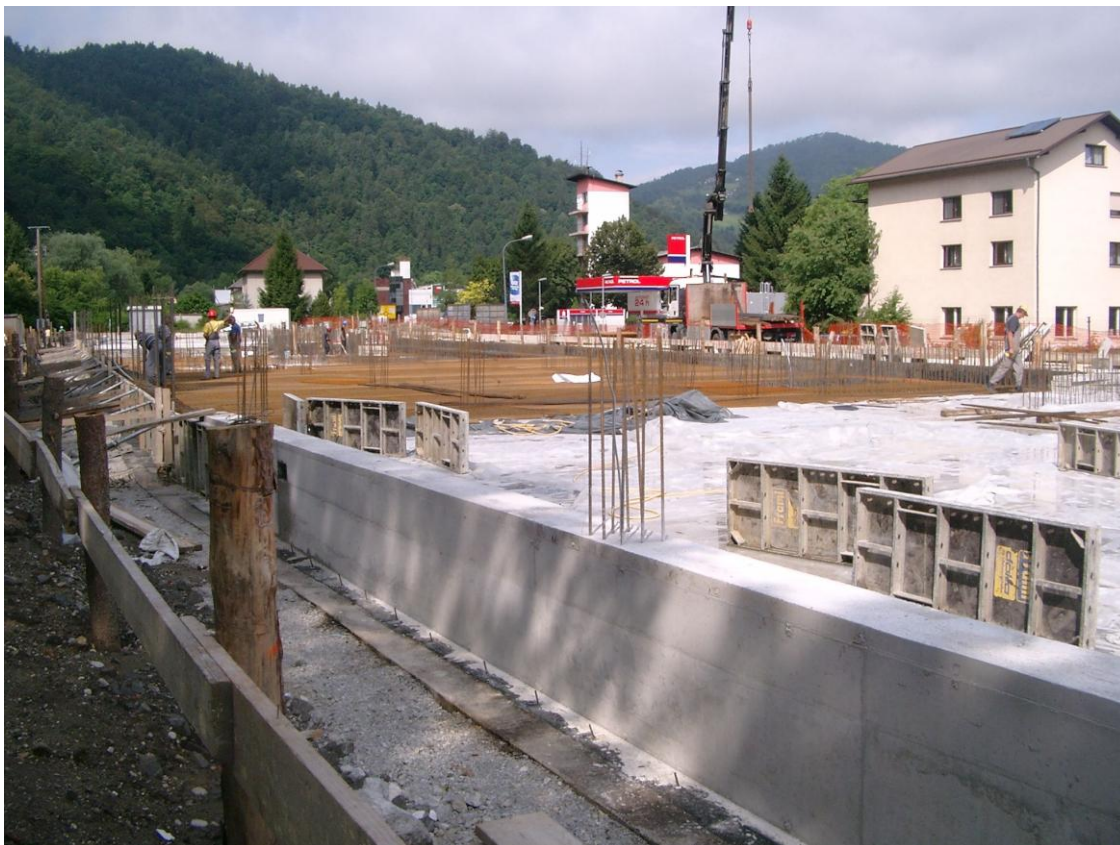
Gradnja temeljne plošče (2011).
