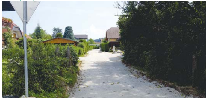
Suhadole – dela so končana, samo še asfalt
