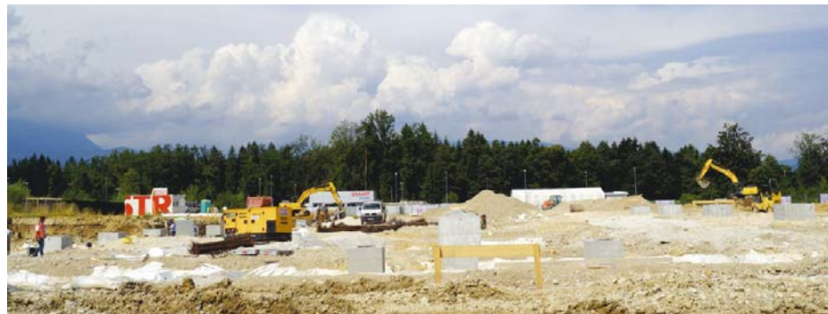
Gradnja Skladiščno poslovnega prostora - Hladilnice Frigolo Komenda
