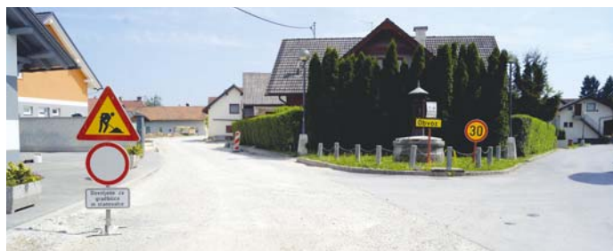
V vzhodnem delu Most so dela končana in bo samo še asfaltiranje
