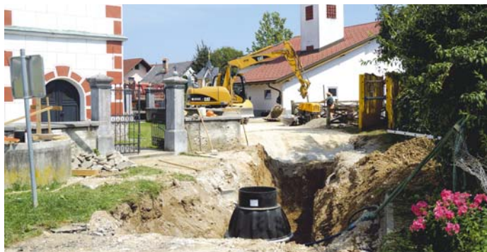
Gradnja kanalizacije in vzporednih naprav v središču Most
