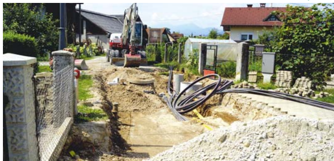
Gradnja vzporedne infrastrukture v Suhadolah
