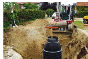
Gradnja v Mostah
