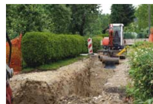
Gradnja v Suhadolah
