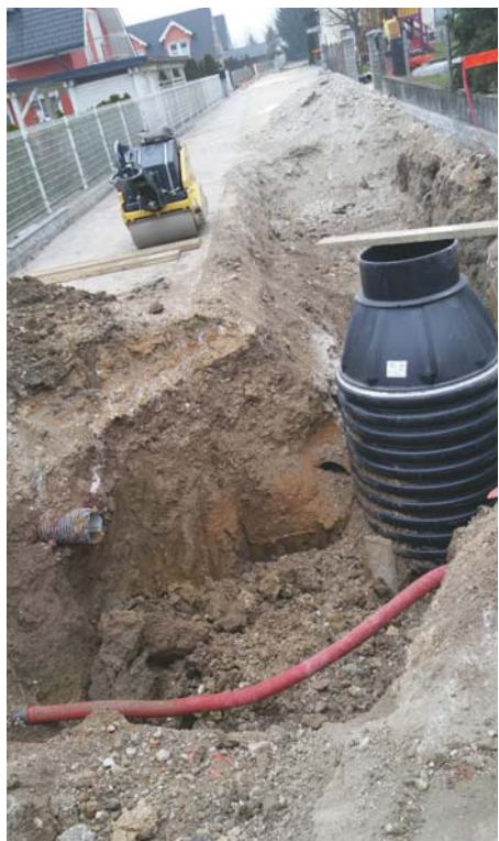
Gradnja za odvajanja in čiščenje odpadnih vod v občini
