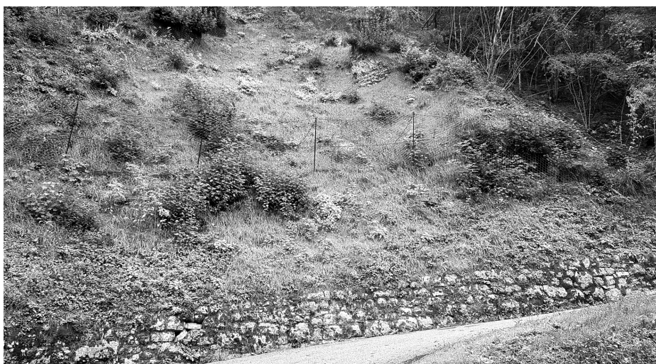
Sanacija plazov Logje na lokalni cesti Breginj–Logje.
