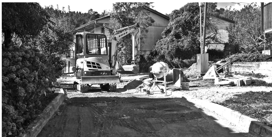
Ureditev vodovoda v Sedlu.
