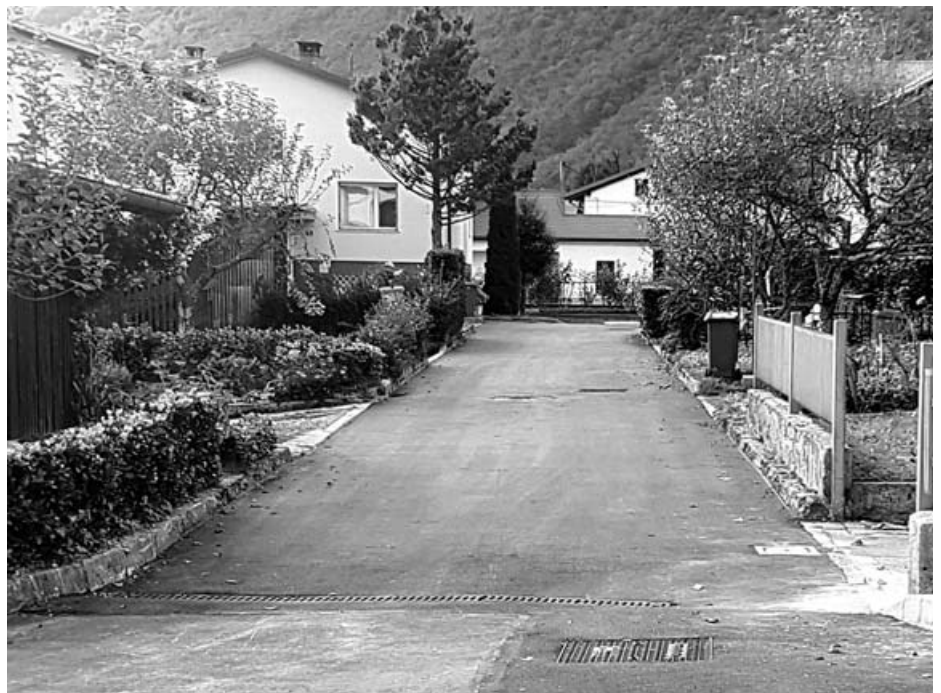
Rekonstrukcija vodovoda in asfaltacija odseka ceste na Ulici Sergeja Mašere v Kobaridu.
