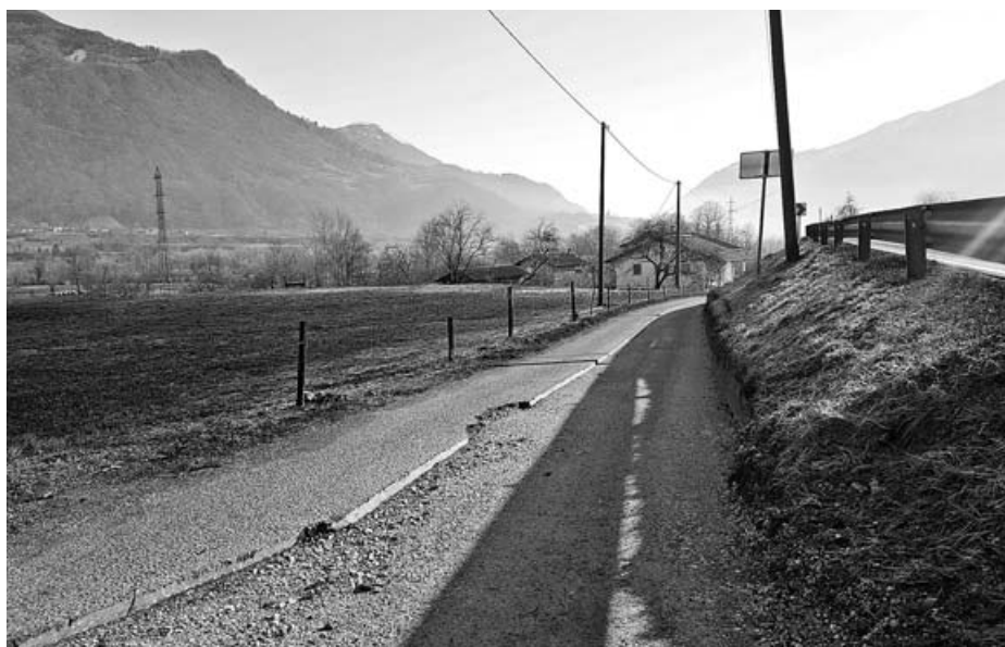
Gradnja kanalizacije s črpališčem in rekonstrukcija vodovoda z oštevcenjem objektov v vasi Idrsko.
