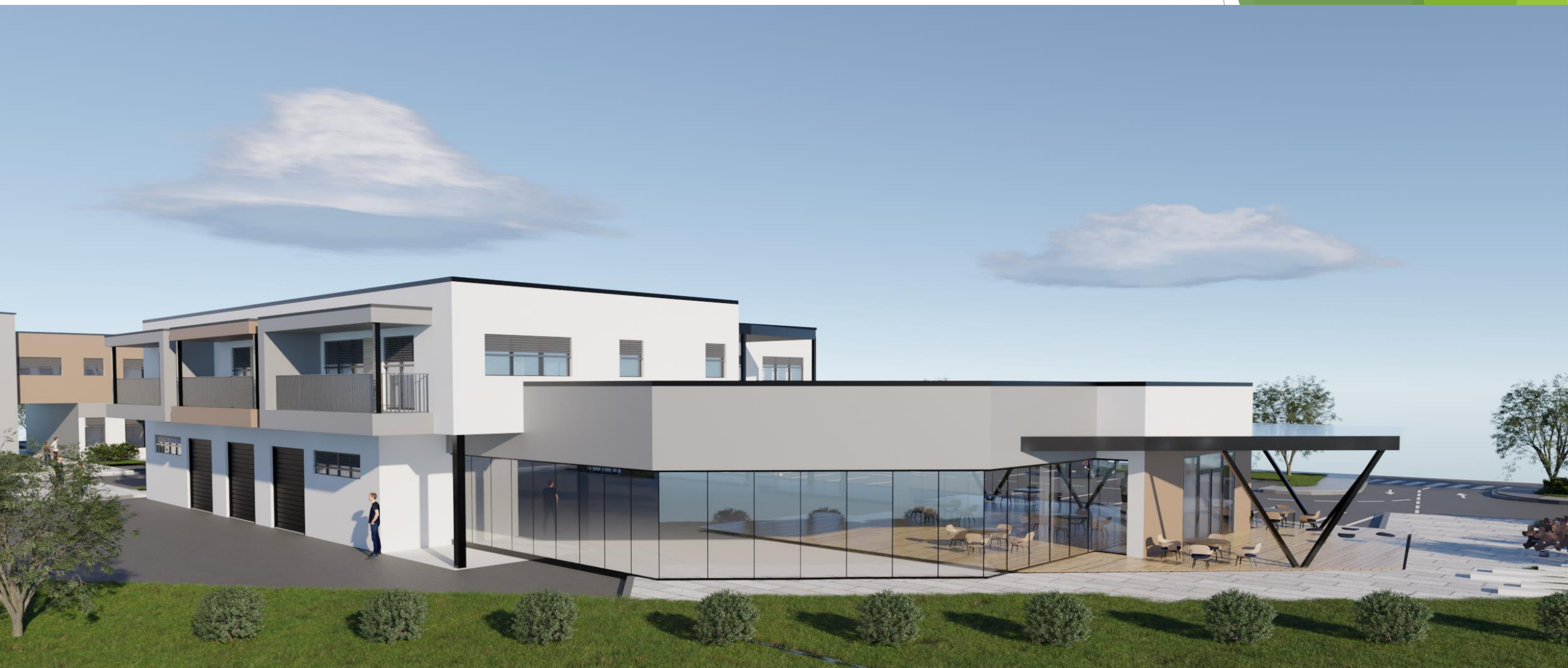
► Objekt 2_pogled jugovzhod
