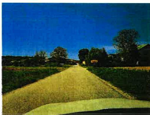
Občina Majšperk, obstoječa lokalna cesta LC – 240111 pred naseljem Sestrže
