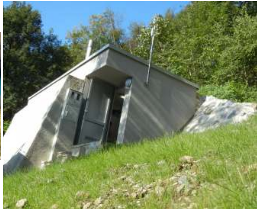
Slika 2: Obnovljen rezervoar z pripravo pitne vode – priključek vodovoda
