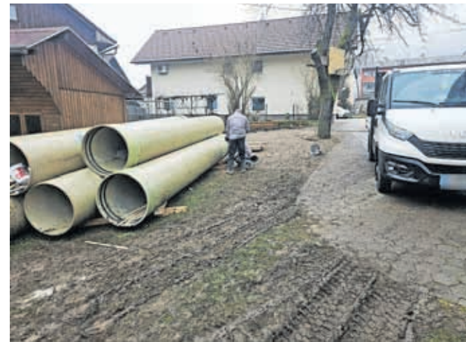
Obnavljajo del dotrajane kanalizacije na Slovenskem Javorniku. / FOTO: ARHIV OBČINE JESENICE
