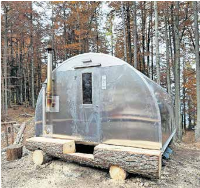
Konstrukcija bivaka in oplata sta iz aluminija, notranjost pa je oblečena v les. / FOTO: ARHIV AO PD JESENICE
