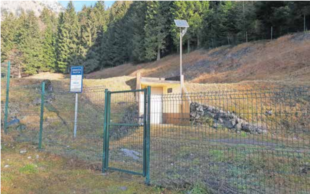
V sklopu projekta prenove vodovodnega sistema Završnica bodo poleg cevovoda zgradili tudi nov vodozbirni objekt Završnica, kjer je v predprostoru predvidena vgradnja naprave za UV dezinfekcijo pitne vode. / FOTO: ARHIV OBČINE ŽIROVNICA
