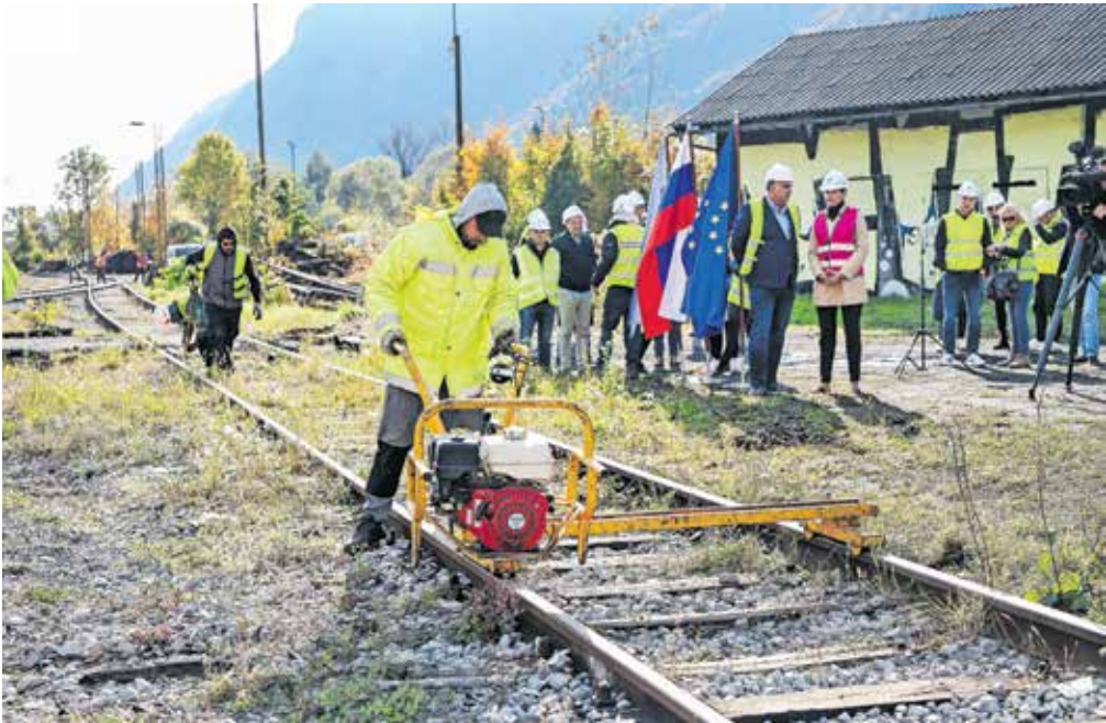
Trenutno na gradbišču poteka odstranjevanje stranskih tirov in kretnic. Ob tem se izvajajo tudi dela v objektu centralne postavljalnice. / FOTO: TINA DOKL
