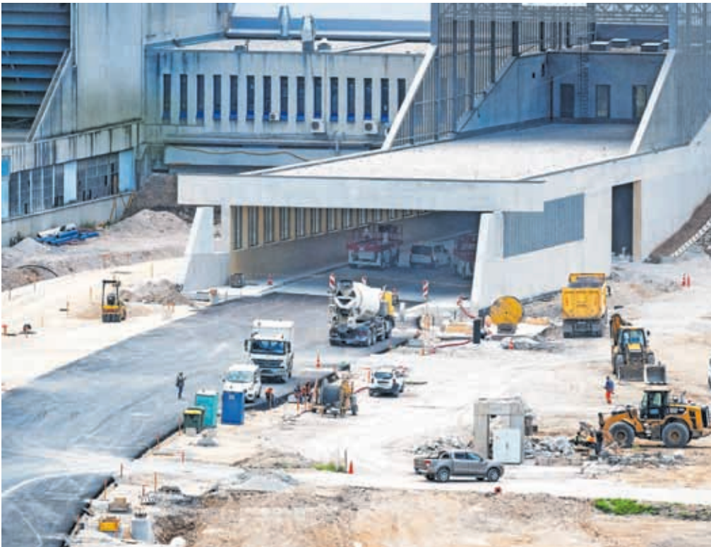
V novi predorski cevi nameščajo elektrostrojno opremo, zunaj predora pa urejajo vozišče. / FOTO: NIK BERTONCELI
