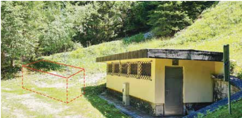
Okrvirna lokacija glavnega jaska – podzemna izvedba
