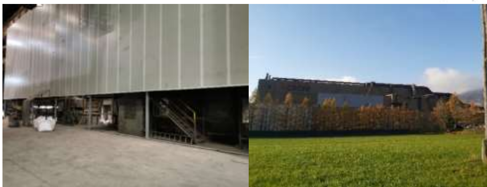
Jeklarna znotraj in zunaj: stena pred elektroobločno pečjo in absorptivna izolacija dela fasade.
