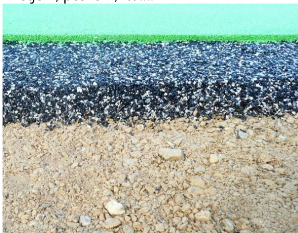
Slika: primer končne izvedbe gumene podlage.
