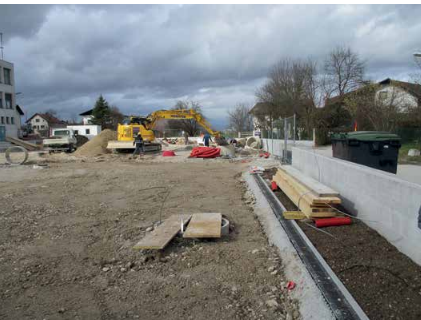
Gradnja igrišča v polnem teku
