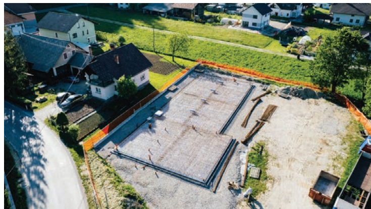
Pogled na vezano armaturo iz zraka
