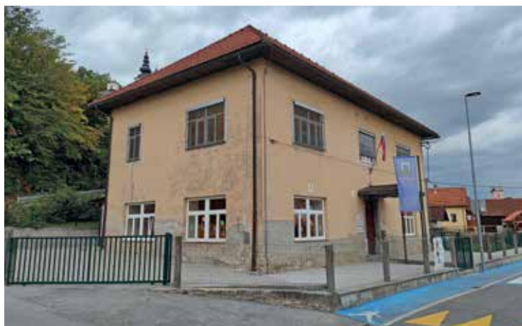
POŠ Tomišelj pred sanacijo
