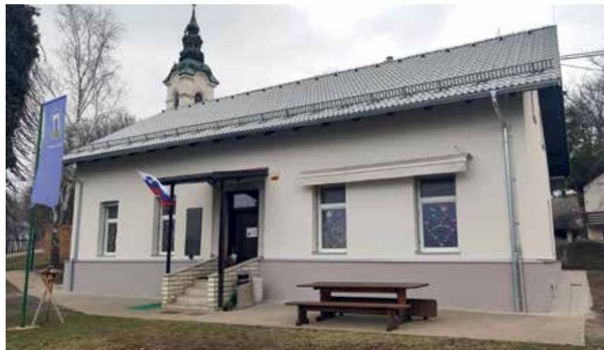
Izgled POŠ Iška vas po končani sanaciji
