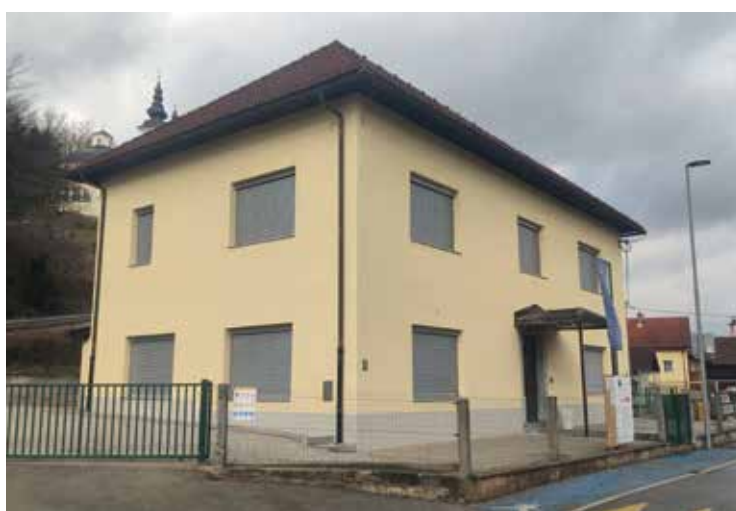
Po zaključeni energetski sanaciji
