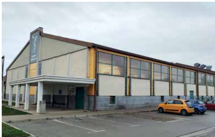
Športna dvorana Ig pred sanacijo
