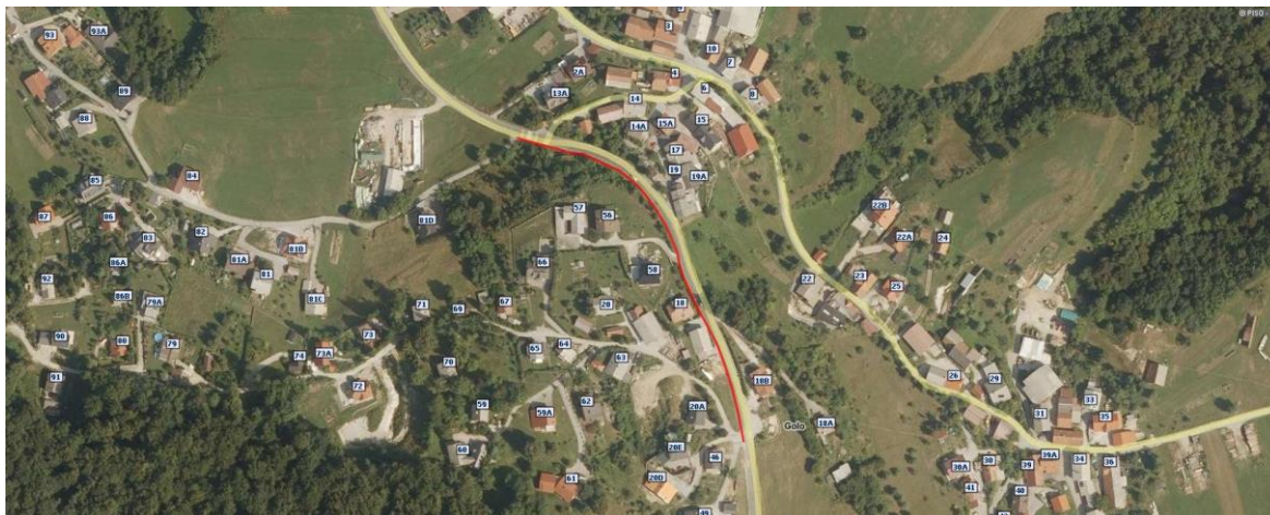
Slika 1: izgradnja pločnika Golo (odsek Gora – Golec) 1 FAZA
