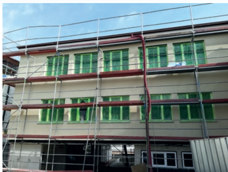
Nastajanje fasade na prizidku k OŠ Ig
