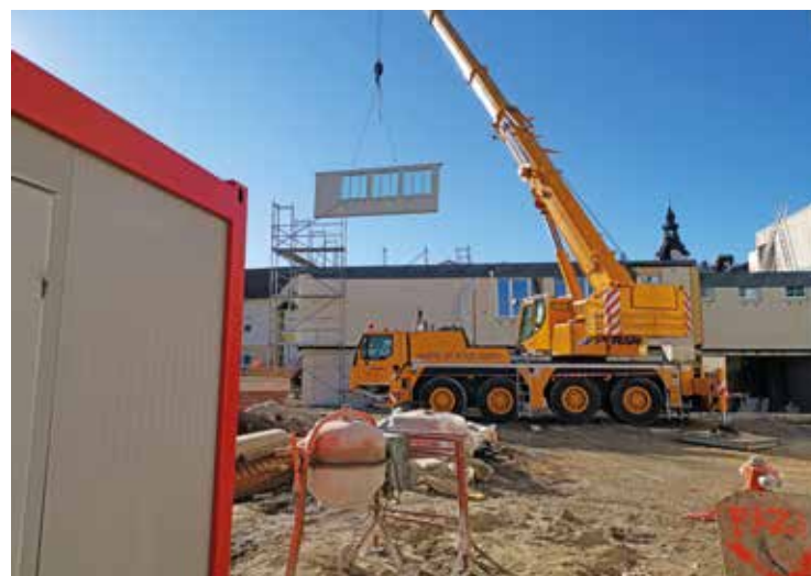
Dela na prizidku k OŠ Ig
