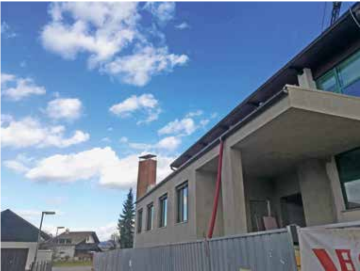
Gradnja prizidka ob Troštovi ulici – 1. faza
