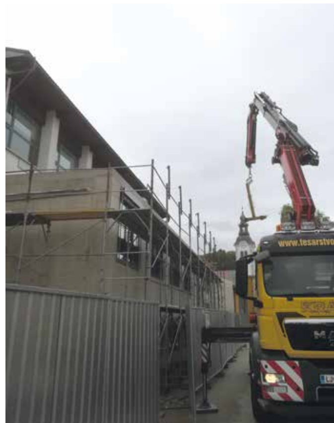
Prizidek na Troštovi ulici (v pritličju kuhinja, v nadstropju zbornica)
