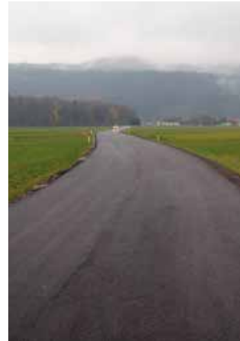
Novi asfalt pri odcepu za Kot
