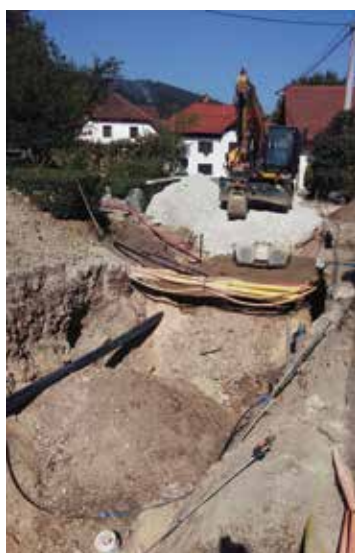
Izgradnja kanalizacije in obnova vodovoda v Tomišlju
