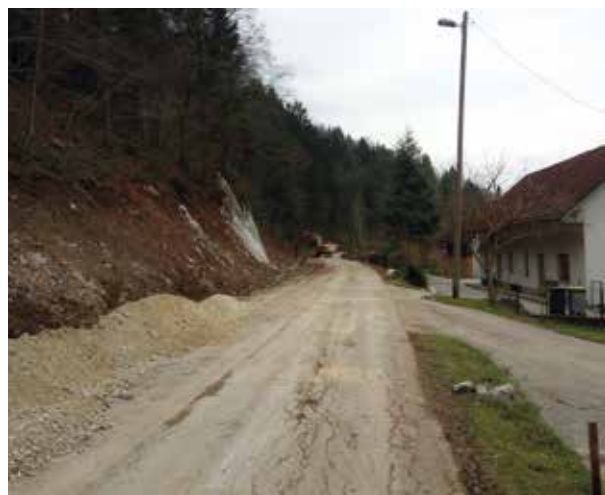
Obnova ceste od Podkraja proti Jezeru
