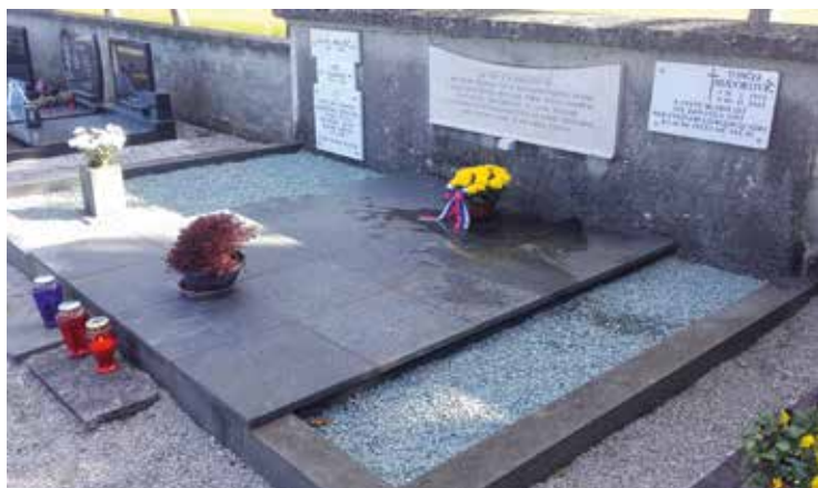
Obnova grobnice v Tomišlju
