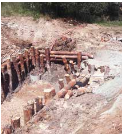
Sanacija kanalizacije čez Ižico
