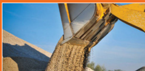
DOBAVA PRODOV, PEŠKOV TER BETONSKIH MEŠANIC
