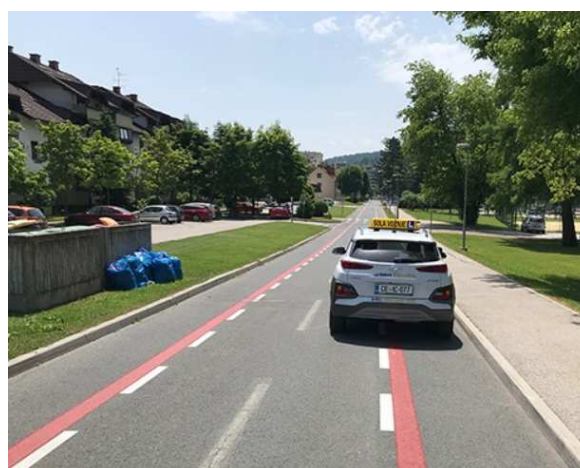
Slika 51: Predlog ureditve normalnega prečnega profila na (levo) s prikazom dejanske uporabe takšnega profila na primeru iz Velenja (desno)
