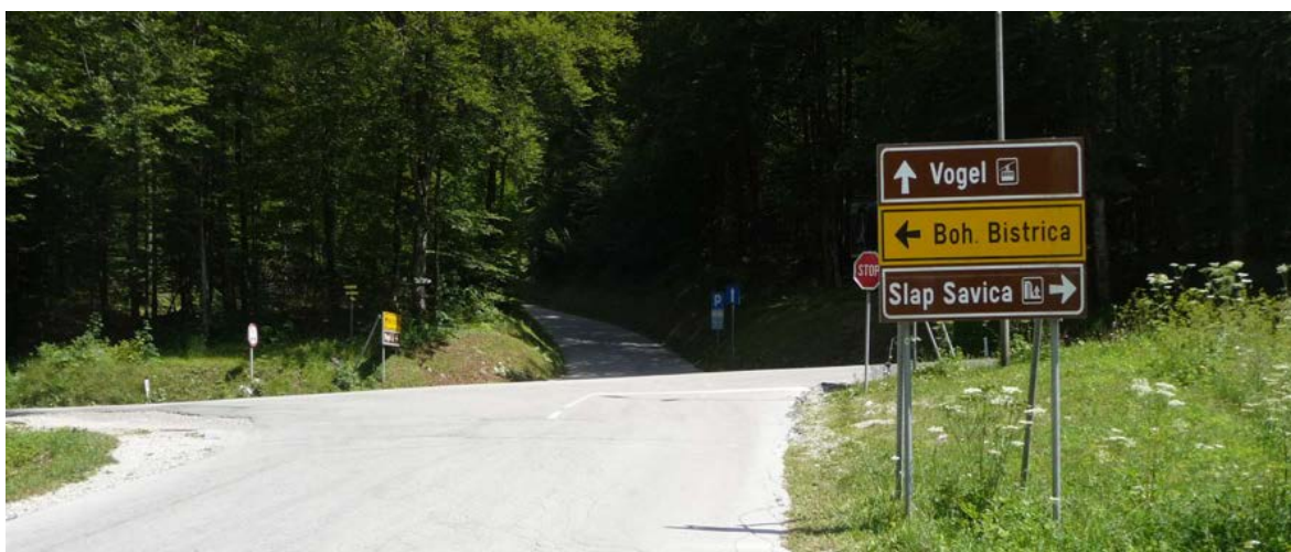
Slika 6 Križišče regionalne ceste RT-904/1093 in lokalne ceste LC 014041
