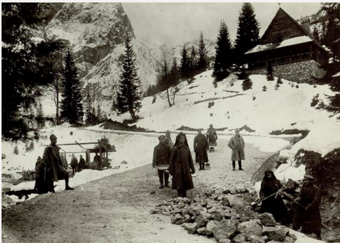
Fotografija 5: ruski ujetniki pri gradnji vršiške ceste.
