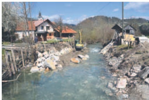
Sanacijska dela na strugi Gradaščice.
