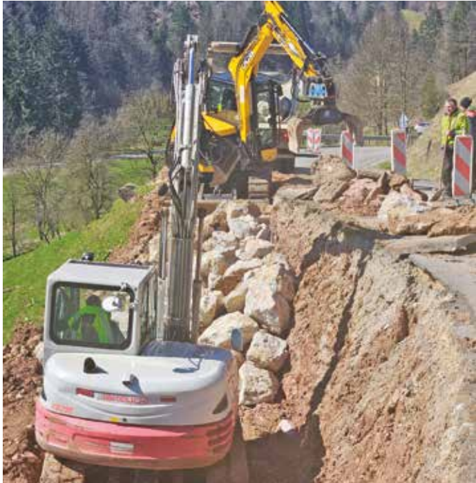
Gradnja kamnite zložbe pod cesto Podlipa–Smrečje
