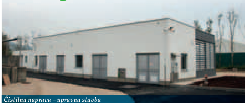
Čistilna naprava – upravna stavba
