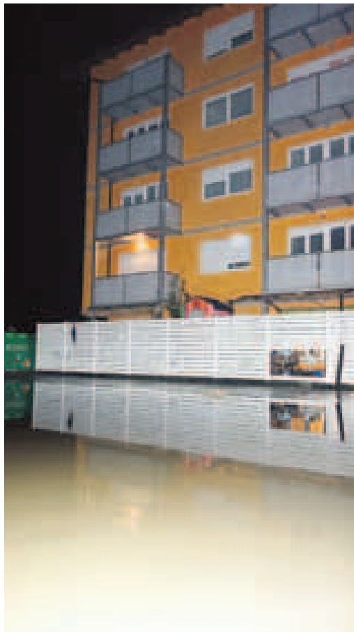
Eurocleanov blok se dviga iz vode.
