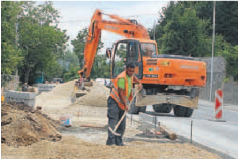
Gradnja kanalizacije na Lukovici
