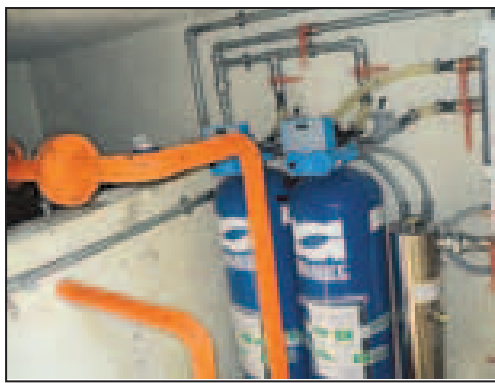
Pogled v »notranjost« butajnovskega vodovoda
