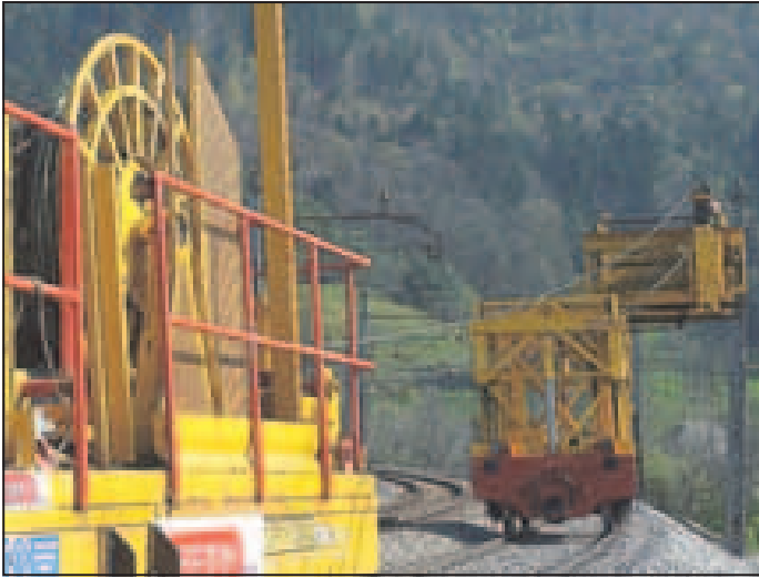
Razstavljanje električnega omrežja je šlo hitro od rok. Obnova pa ...
