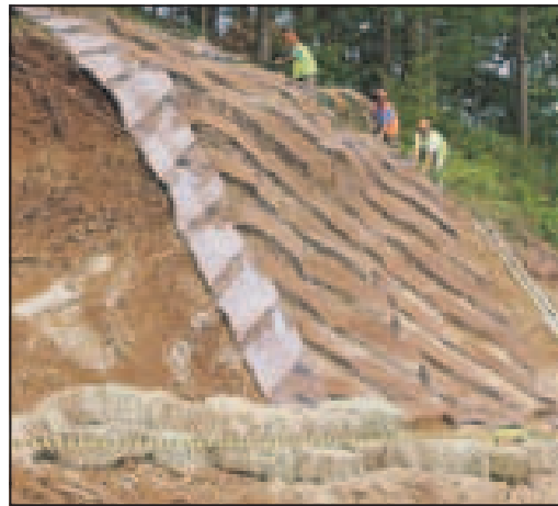
Tehnični del sanacije na Dobrovi ...
