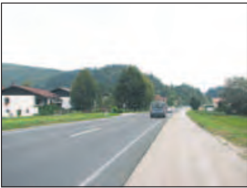
Letos bodo kolesarske steze in pločnike gradili od Lukovice in skoraj do osnovne šole.
