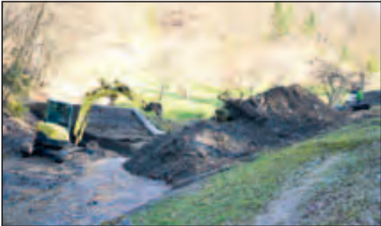
Sanirana pregrada bo zagotavljala stabilnost in zadrževanje plavin ob močnem deževju.
