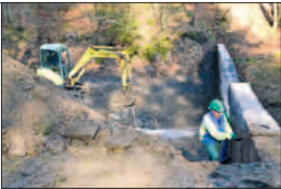
Pregrado na hudourniku Proasca izvaja podjetje Hidrotehnik, d. d.
