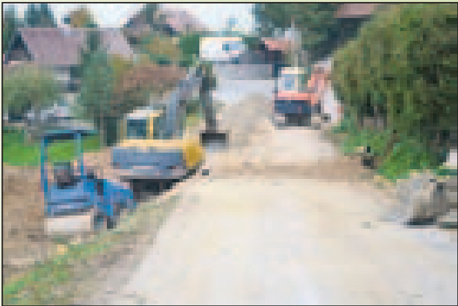
Sanacija del na javni cesti Belica-Babna Gora-Dvor
