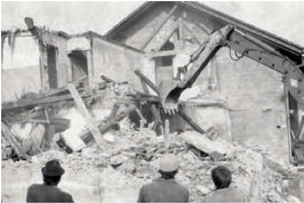
Gradnja kulturnega doma v Šentjoštu
