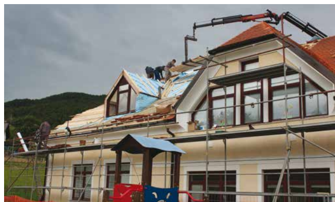
Obnova strehe POŠ Socka
