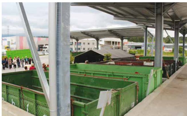
Zbirni center Arclin – nadgradnja
