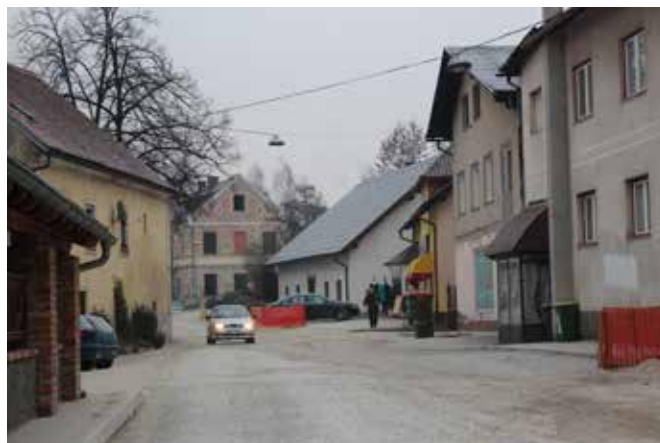
Začelo se bo izvajanje del – obnova vodovoda po Prušnikovi ulici.
