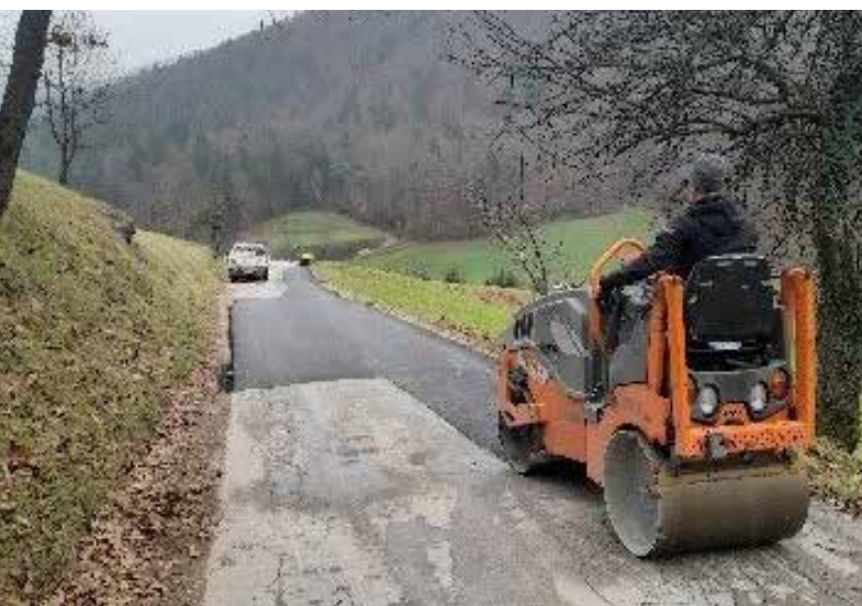
Sanacija asfaltnih površin na cesti v Rovah
