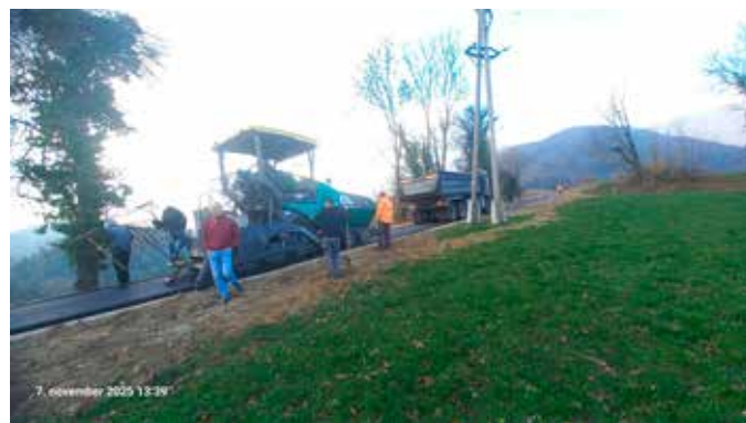
Asfaltiranje ceste v Spodnjem Lindeku
