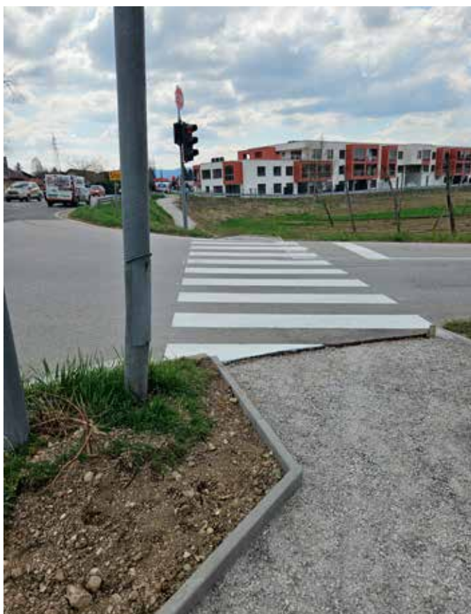
Nadgradnja semaforja z novim prehodom za pešce v križišču državne ceste in Ceste za Šmartno
