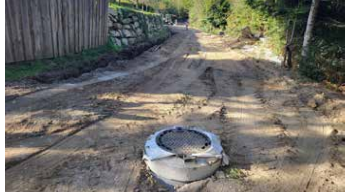
Trasa kanalizacije je potekala po lokalni cesti.
