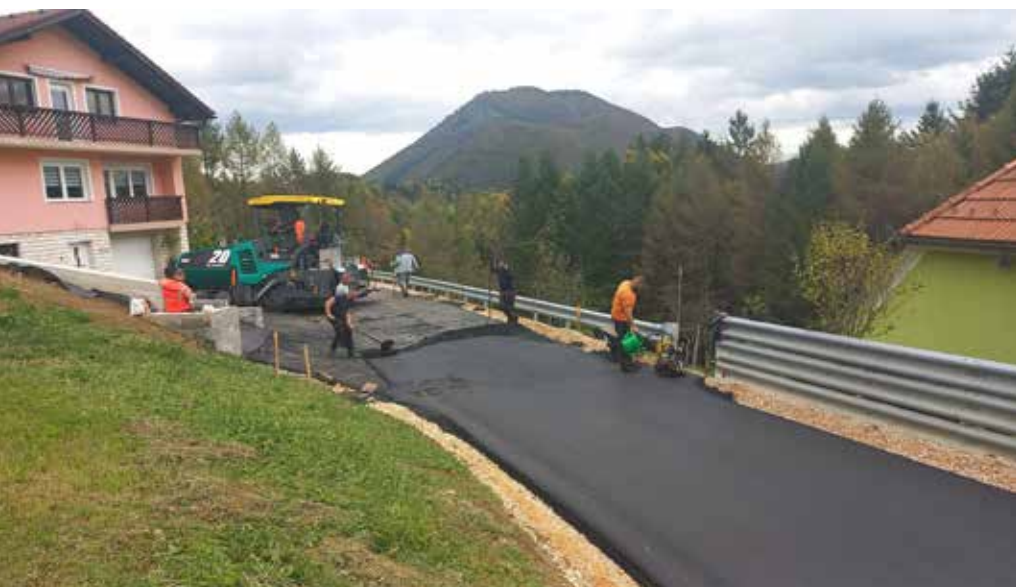
Asfaltiranje lokalne ceste Frankolovo-Socka
