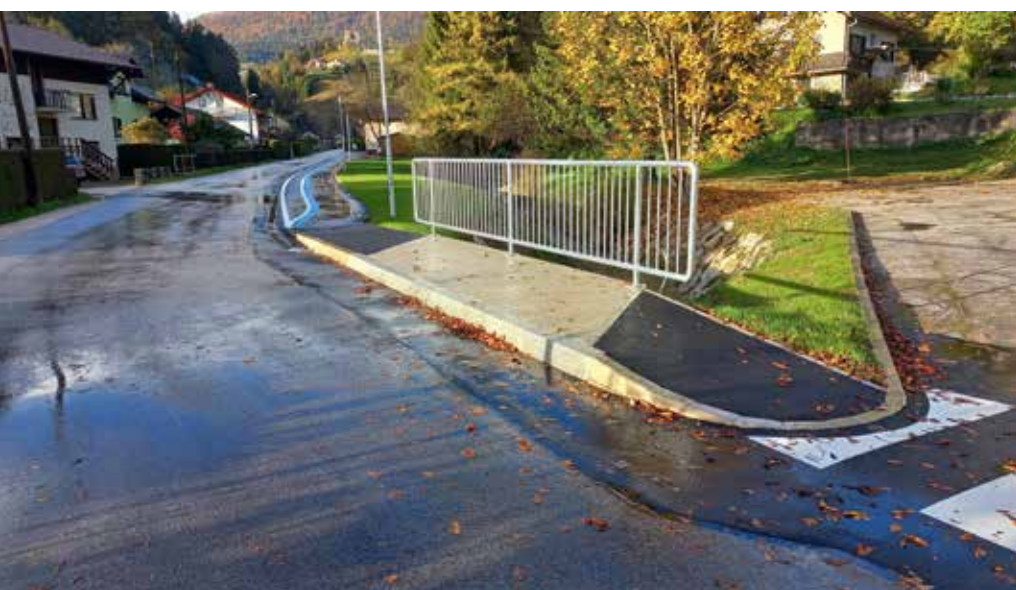
Pločnik za pešce od regionalne ceste do gasilskega doma
