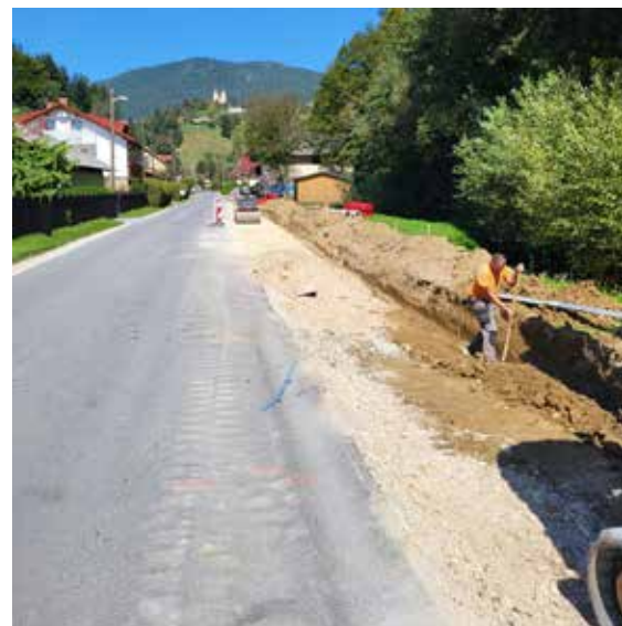
Hodnika za pešce na odseku ceste Frankolovo-Socka v Frankolovem
