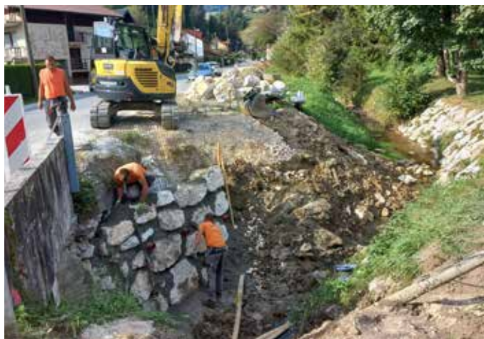
Gradnja pločnika s širitvijo mostu od glavne ceste do stavbe Krajevne skupnosti
