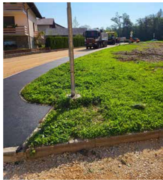
Sanacija asfaltne na Ulici Stanka Kvedra
