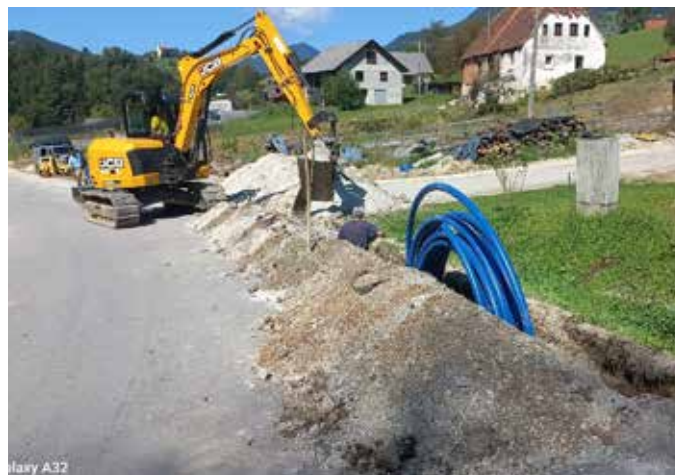
Gradnja vodovoda v naselju Verpete
