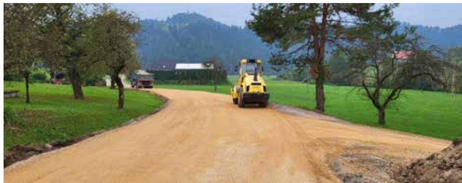
Rekonstrukcija lokalne ceste Ilovca - Jankova
