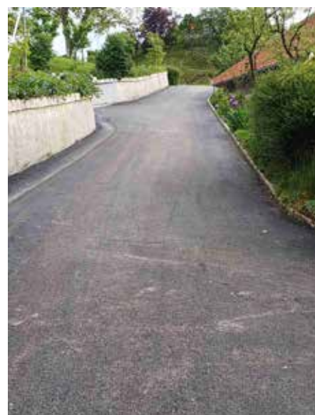
Obnovljeno cestišče v Novakah
