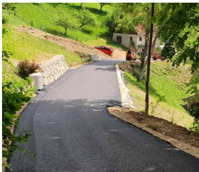
Asfaltiranje ceste v Lipi
